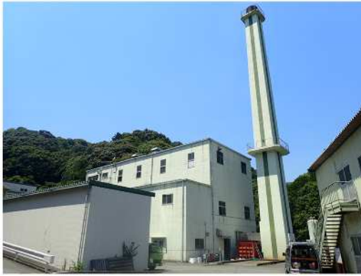
【クリーンセンターなんとう(焼却処理施設・粗大ゴミ処理施設等)】
