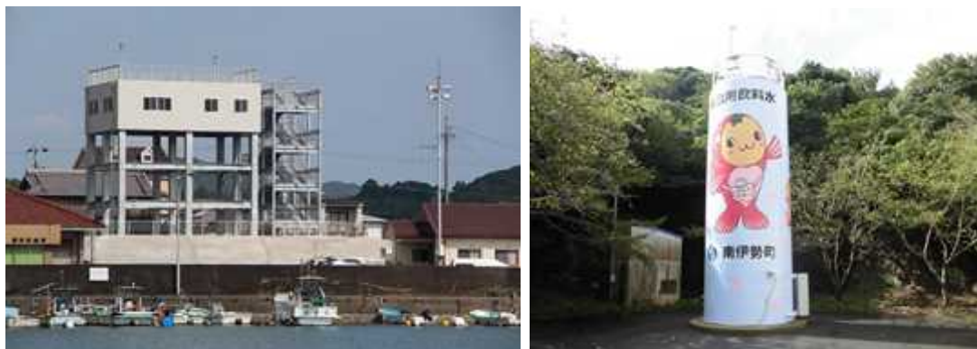
写真 1-2 津波避難タワー・緊急用飲料水浄化装置(避難所設置)
