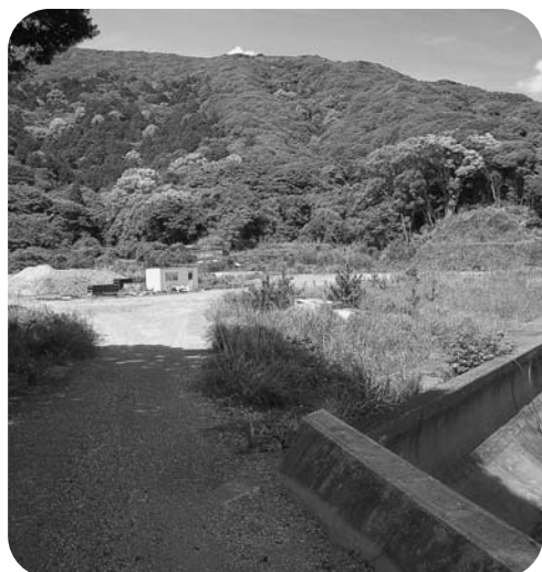
相賀浦下水道処理場の建設予定地
