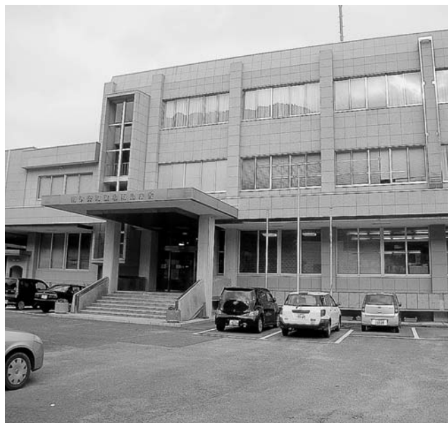
南島庁舎耐震対策は？
