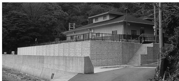
すべり出しが順調な神前浦地区下水道最終処分場
