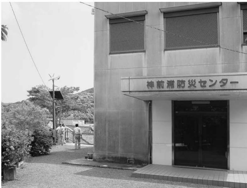
見直しが急務な防災センター
