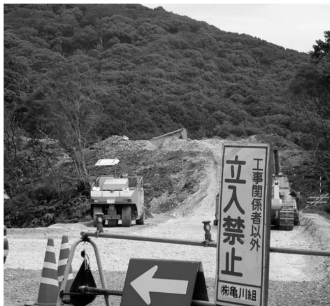
進む国道整備（木谷工区）
