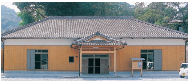
完成間近の東宮資料保存館
