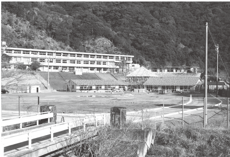
建設中の統合保育園
