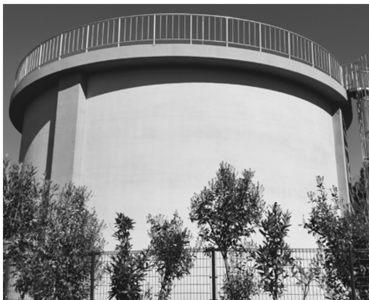
高台にある配水池
