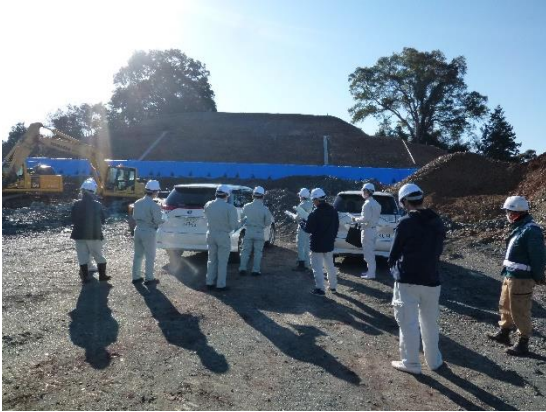
R3.12.15 統合保育所建設現場視察
