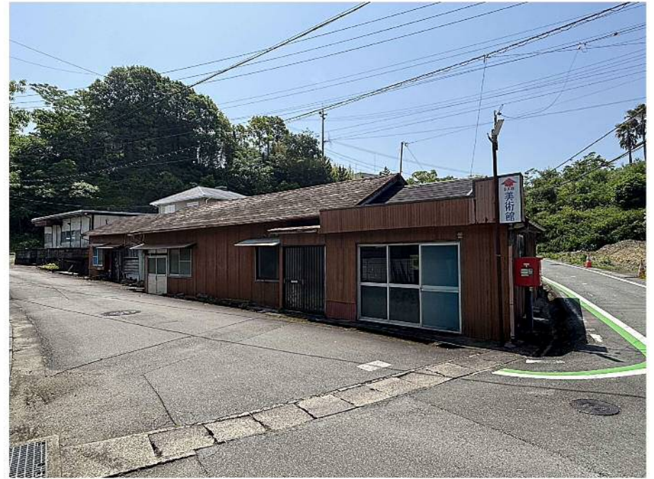
A棟C棟 北側から撮影
