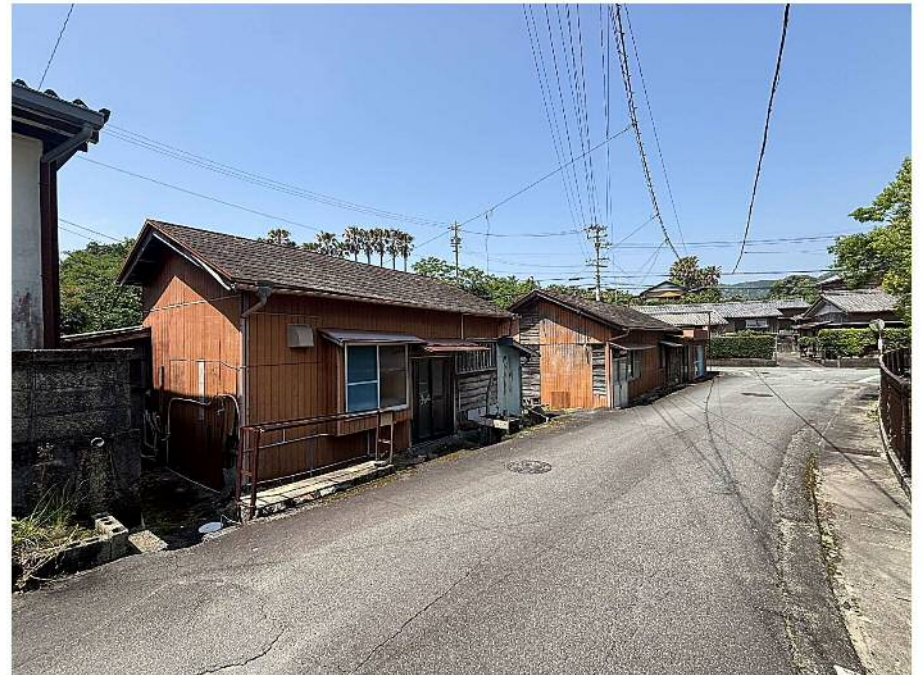
A棟C棟 東側から撮影
