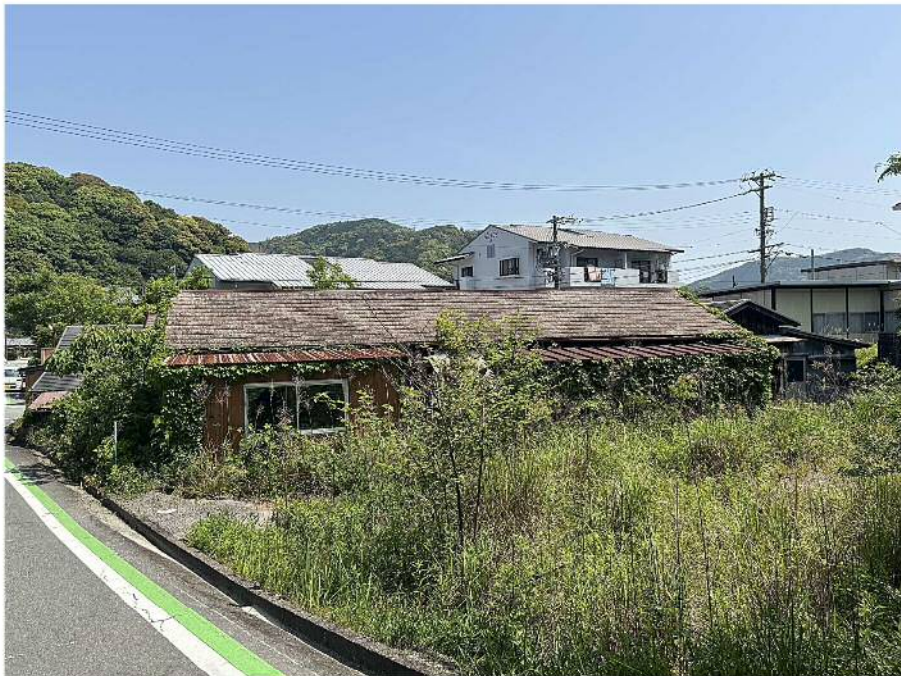
B棟 南側から撮影
