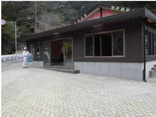
小さな拠点改修工事（完成）
