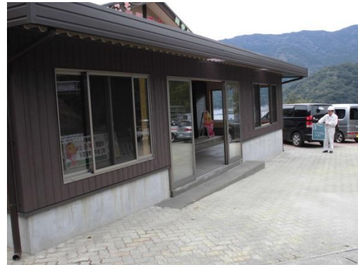
小さな拠点改修工事（完成）
